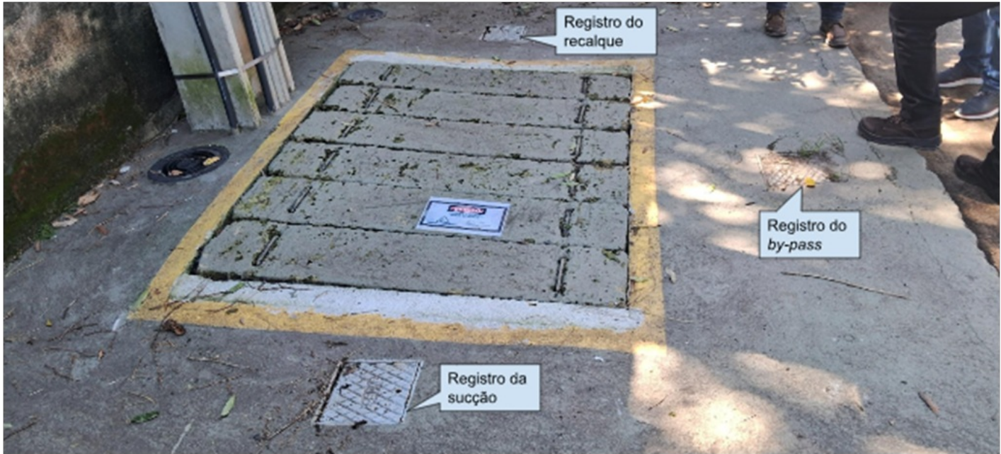
Foto 1 - Vista do tampão múltiplo de concreto e das caixas dos registros.
