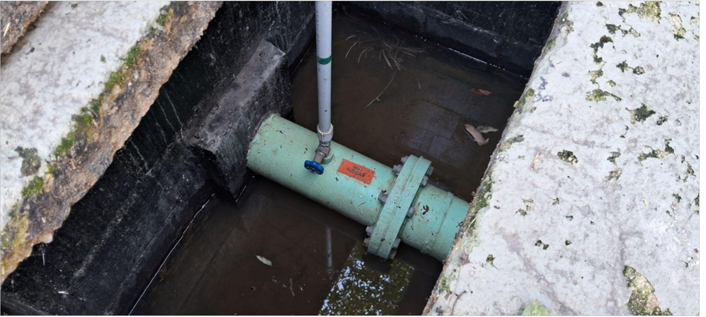
Foto 3 – Tubulação de sucção.
